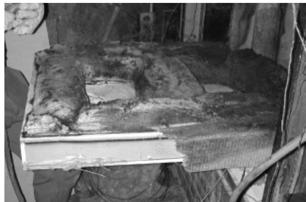
Konstruktion eines Verbundpartners nach Brandversuch
