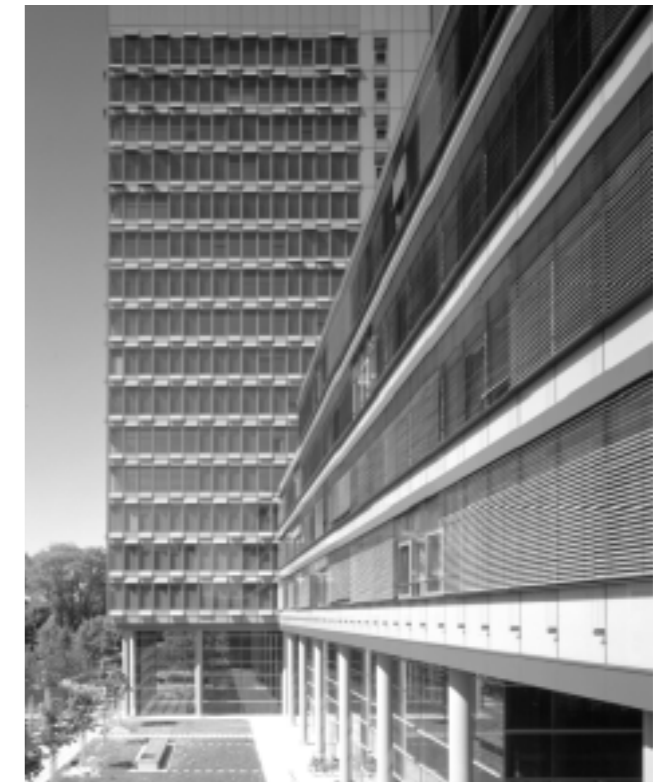
Das Fraunhofer-Haus in München wird weitgehend frei belüftet und im Sommer über Nachtlüftung und Bauteilkühlung passiv gekühlt. Im Bild ist der Sonnenschutz im Querbau sichtbar. Im Hochhaus sind die Lüftungsklappen der Doppelfassade geöffnet.
